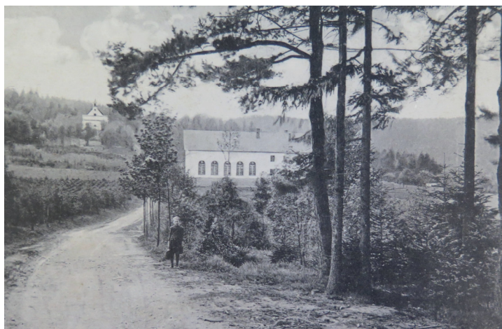
Lázně Na Horách s kaplí P. Marie Pomocné nad zázračnou studánkou. Vpravo nová budova restaurace se sálem z r. 1869; 1. třetina 20. století
