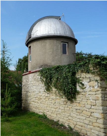
Stradouňská hvězdárna v roce 2008
