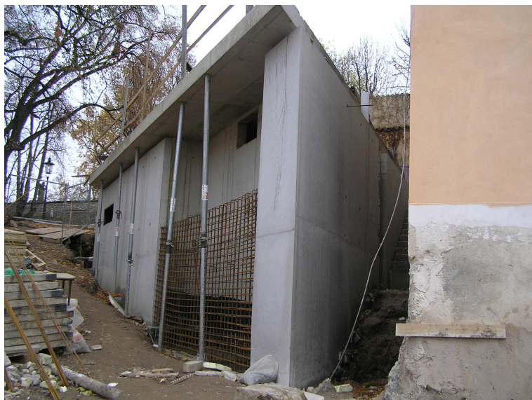
Spodní část budoucího vstupního objektu muzea na bývalém dvorečku. Betonový polosuterén na snímku obsáhne technické zázemí, nahoře vyroste konstrukce vlastního foyer. Vpravo prostor přístupového schodiště. foto René Klimeš 23. 10. 2013
